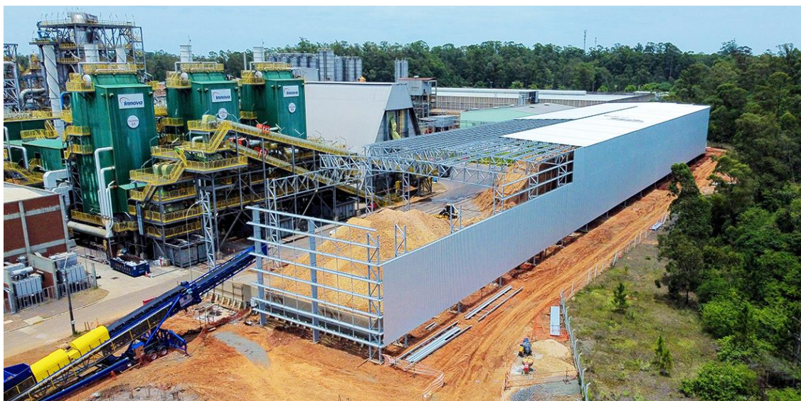
Unidade II, Triunfo (RS), petroquímica: implantação da cobertura do pátio da biomassa.
