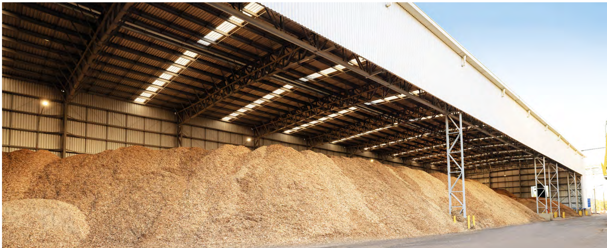
Unidade II, Triunfo (RS), petroquímica: pátio de biomassa de resíduos vegetais, fonte de energia renovável que abastece a Central de Geração de Vapor e Energia Elétrica.
